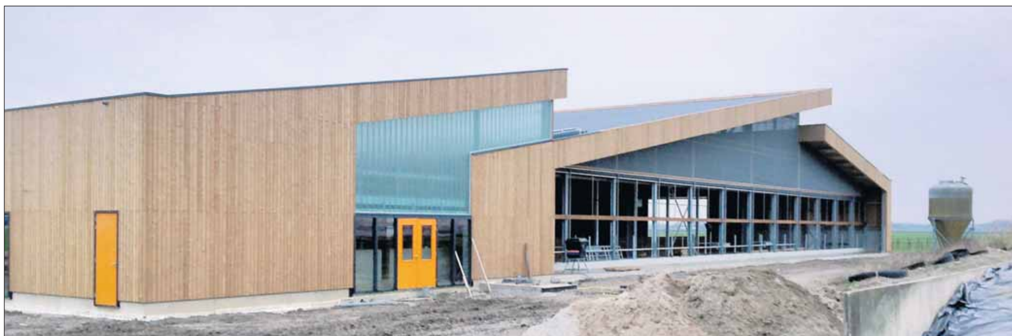
Op de grote, schuine zijdes van het dak van Aeres Praktijkcentrum Dronten komen zonnepanelen en het overige deel van het dak wordt gebruikt als moerasdak.
